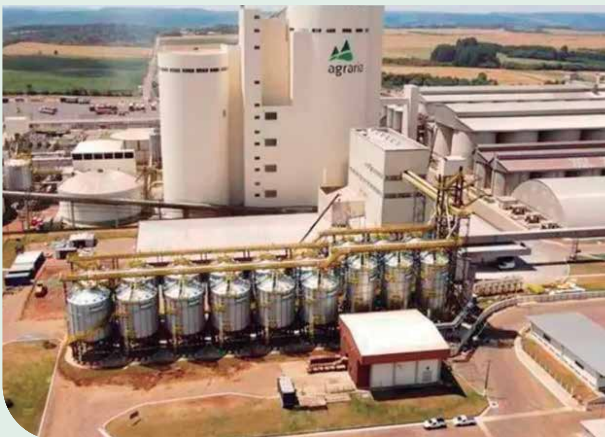
Nova unidade será construída junto à atual planta de produção de malte da Agrária, em Guarapuava
